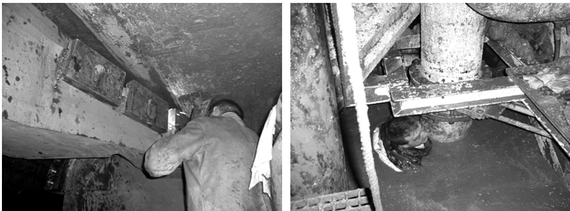
Bild 1 Arbeiten unter Druckluft (4. Röhre Elbtunnel) - Schweißen auf der Rückseite des Schneidrades aufgrund von sehr großem Verschleiß (links) sowie Reparaturarbeiten am Steinbrecher (rechts)
